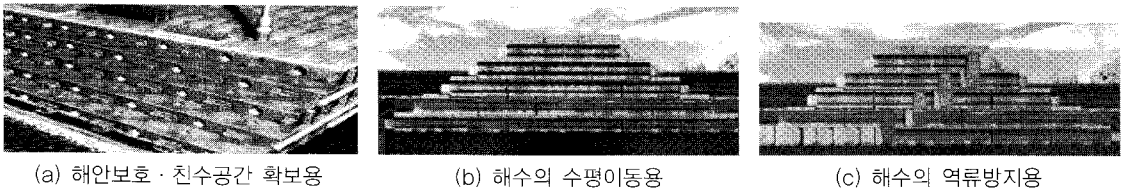
그림 3. 해수유통 구조물의 기능별 · 용도별 설치 예
