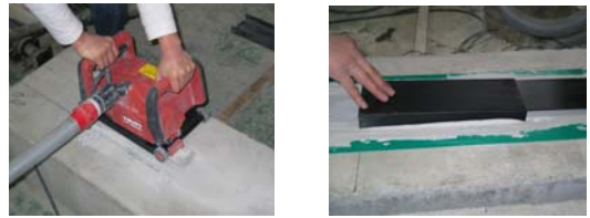
Fig. 4 보강섬유 정착판 시공순서
