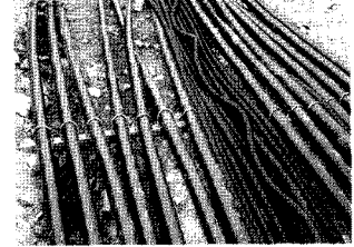
6. 트렌치 배관 작업
