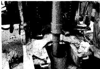
4. 내부 케이싱 설치작업
