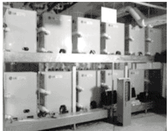
[그림 12] 지열이용 VRF 시스템의 설치 건물의 기계실 및 실내기 설치모습
