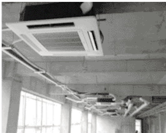
[그림 12] 지열이용 VRF 시스템의 설치 건물의 기계실 및 실내기 설치모습
