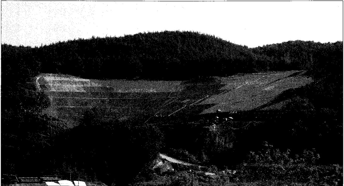
그림 7. 두동 제2터널 개착(중점)부 시공 전경사진
