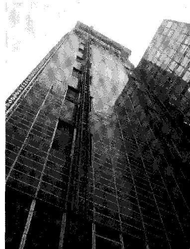
〈그림 2〉 시공중 CIS Tower의 전경 3)
