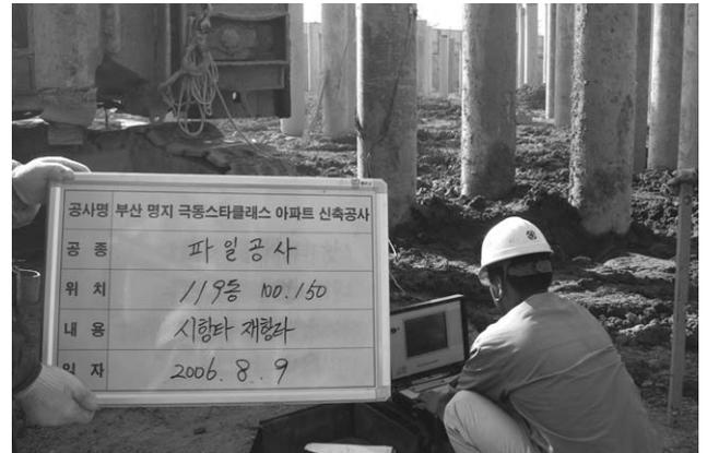
진 구간에서는 주변마찰력의 증가량은 크지 않으나 시공정도에 따라 구간별로 증가량의 차이가 있으며, Cement-paste 충전 구간에서는 주변마찰력이 점진적으로 증가하지만 최종 타격구간에서의 주변마찰력 증가량은 모두 급격히 감소하는 것으로 나타났다. 이는 시간경과에 의한 주변마찰력의 감소가 아니라 재항타시험 시의 타격에너지의 부족에 의한 것으로 시험말뚝의 실제 주변마찰력을 과소평가한 것으로 판단할 수 있다.
