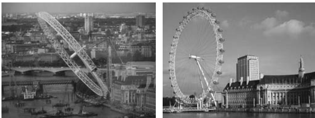
<그림 2> 런던아이 양중 과정과 완성 후 전경
