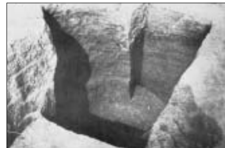
사진 5. 금강사지 목탑지 심초부 구조와 판축도현황 (國立博物館, 1969, 위의 책, p.14)
