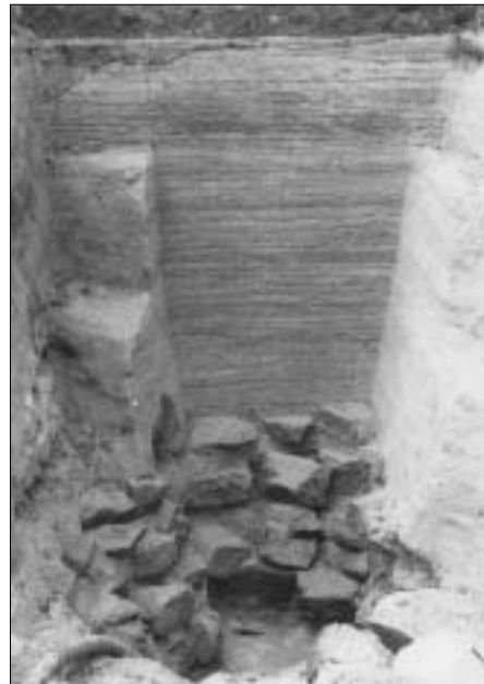
사진 8. 미륵사지 목탑지 기단 내부 판축상태
