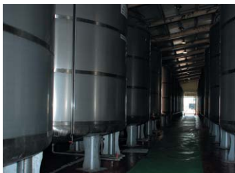
장성공장 맥실주 원액저장시설
