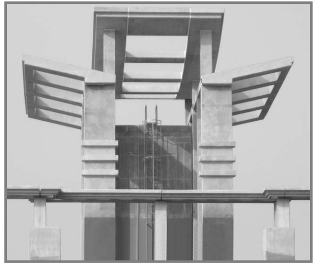
[그림 4] 수원 매탄 두산코오롱 현장
