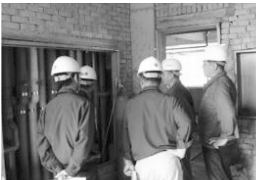
제5회현장점검 : 운동초등학교 교사 신축 기계설비공사
