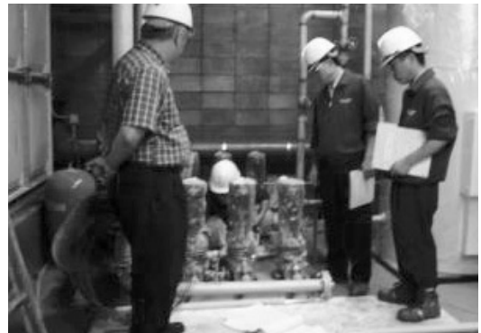
제4회현장점검 : 목령초등학교 교사신축 기계설비공사
