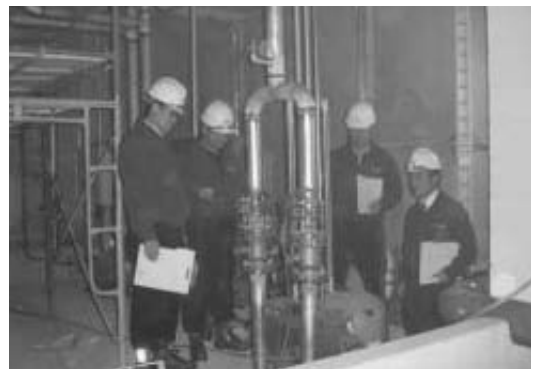
제6회현장점검 : 셋별초등학교 교사 신축 기계설비공사
