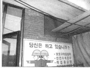
[ 세면장 창문 : 개방하기가 곤란함 ]
