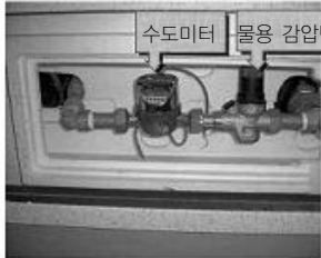
수도미터, 물용 감압변 설치
