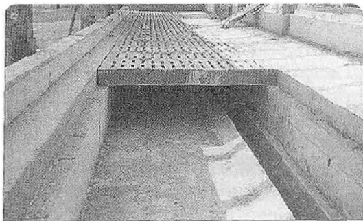
Flachkanal-Rinnenentmistung: Zwischen leitender Halbschale und dem ebenen Kanalboden befindet sich eine Staunase
