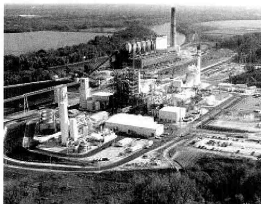
그림 1 Wabash River IGCC 플랜트
