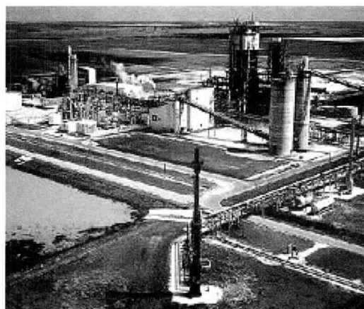
그림 2 Polk Power Station IGCC 플랜트
