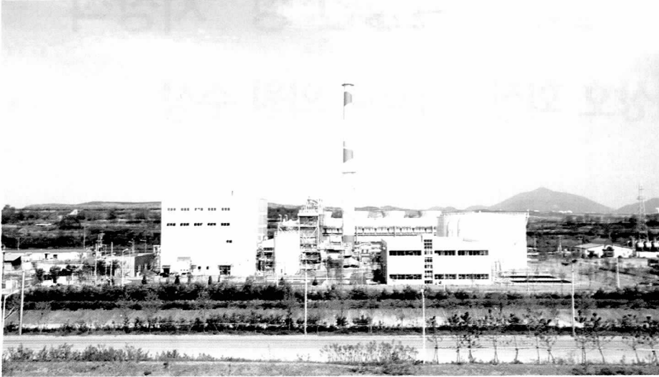
▲ 인천시 백석동에 위치한 수도권매립지내 세계최대 매립가스 발전소 전경.
