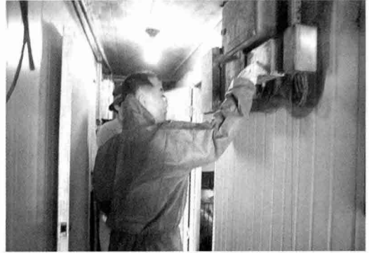
<그림 5> 일교차가 큰 시기에는 하루 중 최저 온도(새벽 6~7시)에 맞춰 환기량을 결정해주는 것이 좋다. 또한 각 농장의 온도조절 컨트롤러의 경우 각 제조사마다 프로그램된 회전 RPM의 차이가 있으므로 환기팬 용량에 맞는 최소 환기량을 농장주들이 파악하고 있어야 적절한 배기를 통한 저산소증을 예방할 수 있다.
