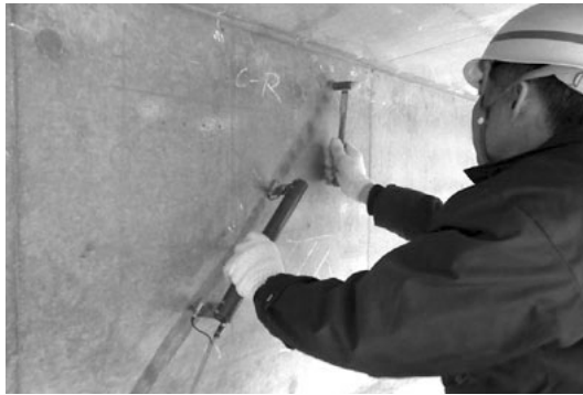
교량 상부공의 주 보 측면의 측정상황
