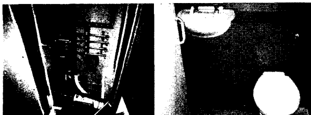
그림 9. 내부 부품 설치
