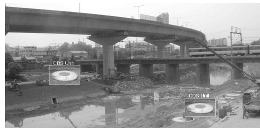
그림 7. 청계천 인근에 설치된 와류필터형 비점오염 처리시설.
