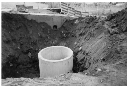
(a) 시공 중
