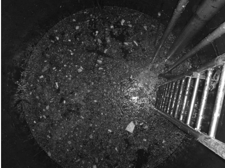
그림 8. 와류필터형 시설에서의 강우유출수의 성상.
