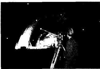
천단침하/내공변위 계측 현장
