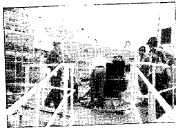
Fig 9. 현장 점검 사진
