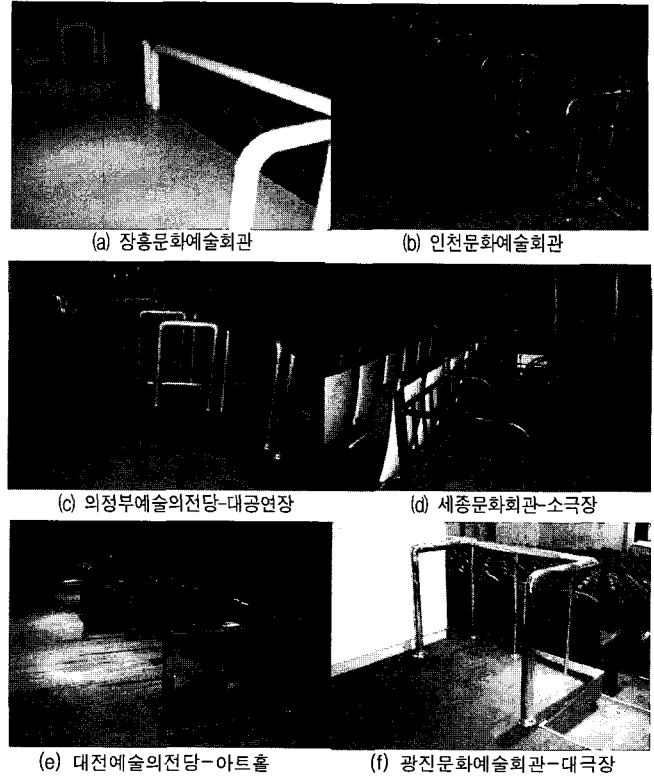
<그림 14> 장애인 객석의 보호 난간의 잘못된 설치 예
