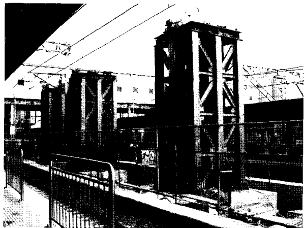
〈그림 11〉 저상홈 가설 Bent
