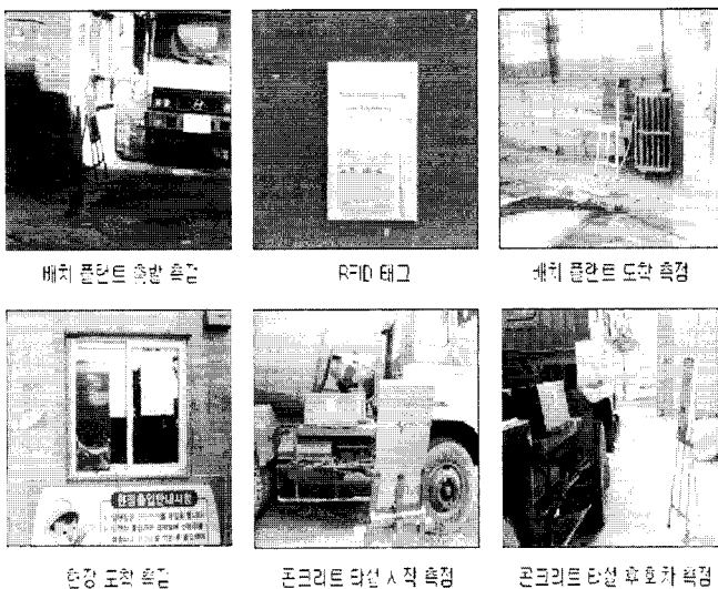
그림 6. RFID 태그 기술을 적용한 콘크리트 타설 프로세스
