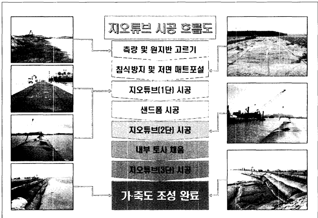
그림 7. Geo-Tube 시공순서도
