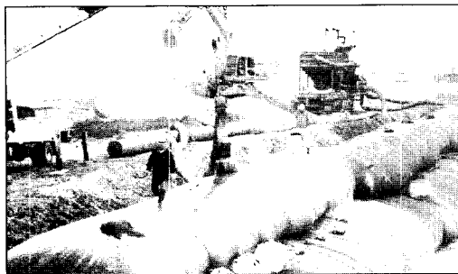
그림 17. Geo-Tube 3단 모래주입
