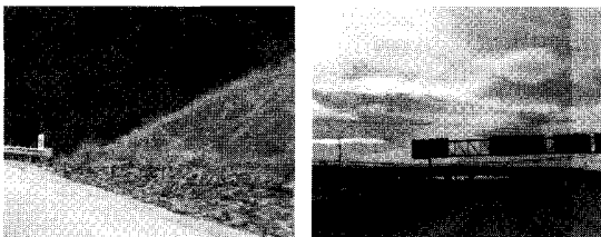
그림 5. 캘리포니아 80번 Freeway 노변에 설치되어 있는 침투도랑의 설치 예
