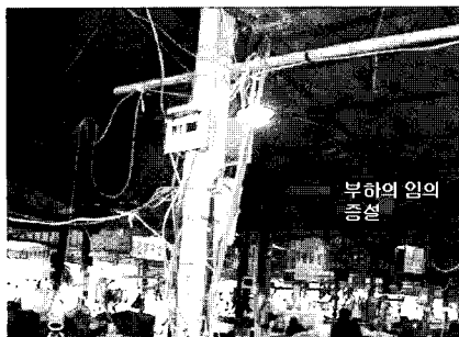
그림 3. 부적합 설비 예시(난잡 배선)
