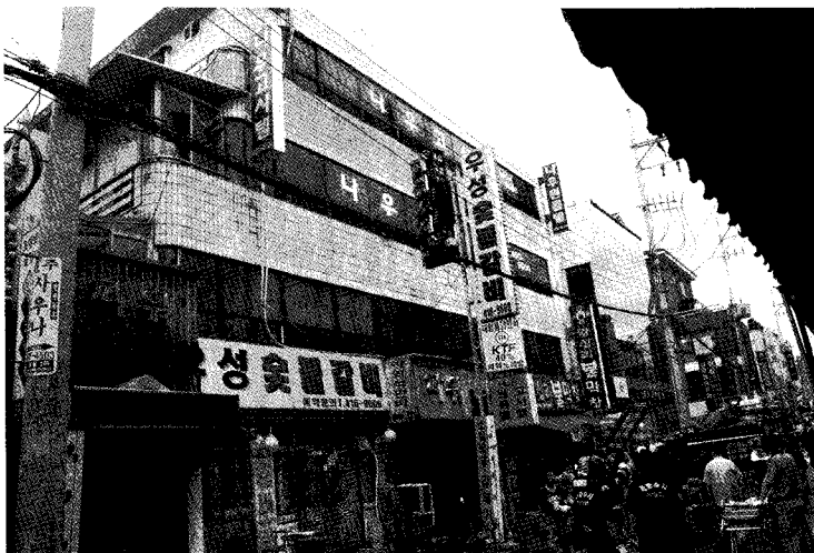
〈사진 2-1 화재현장 전경〉
