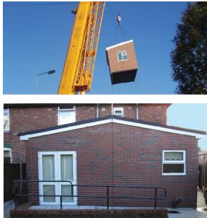
(a) 모듈의 양중 및 설치 모습
