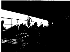
(f) 상부 슬라브 철근 및 PT 조정 - 상부 슬라브의 철근 및 PT등을 조정하여 최종 조립 상태를 확인하고 검측
