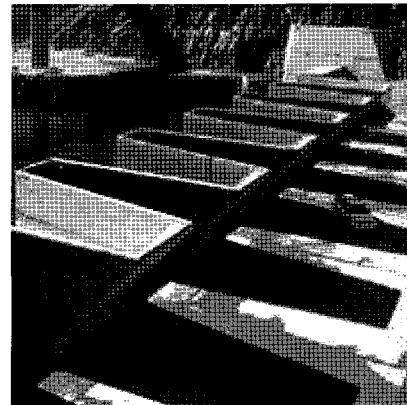
그림 2. Labyrinth-crested fuse gate(Terminus Dam, California)
