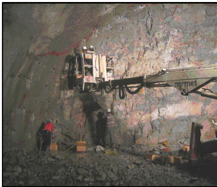
그림 16 천단 침하볼트 설치.
