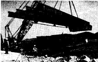
5. 상부거더 지조립 후 거치
