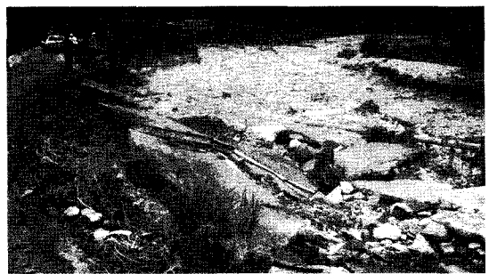
사진 1. 신평천 중류부 제방유실로 인근농경지 토석류 피해, 도로부 유실 전경
