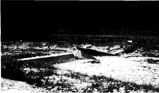
사진 4. 복내천 보 파손(좌) 및 보 직하류 우안 호안 유실(우) 전경
