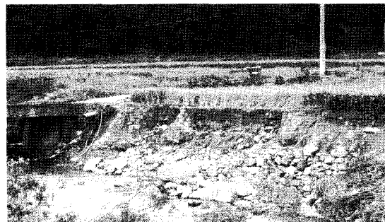
사진 5. 일봉천 보 및 교량 직하류부 호안 유실 전경
