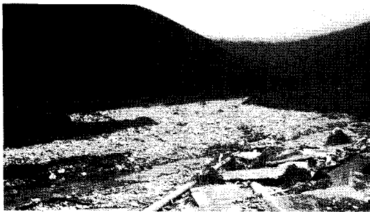
사진 1. 신평천 중류부 제방유실로 인근농경지 토석류 피해, 도로부 유실 전경
