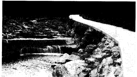
사진 9. 현천천 낙차공과 아치교량 연결부 호안유실(좌) 보 물받이 및 호안유실(우)
