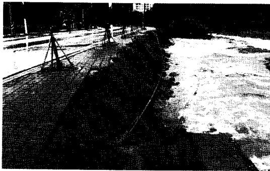
사진 8. 서시천 호안 및 도로 유실 전경
