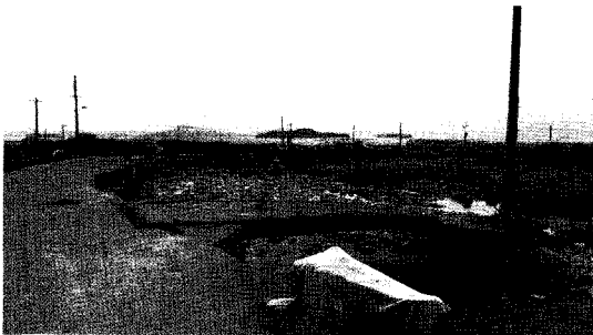
사진 3. 성치천 제방·도로·교량·농경지 피해(좌), 하상세굴로 비탈뒹기 노출(우)
