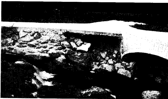
사진 9. 현천천 낙차공과 아치교량 연결부 호안유실(좌) 보 물받이 및 호안유실(우)
