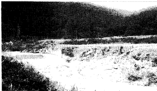
사진 5. 일봉천 보 및 교량 직하류부 호안 유실 전경
