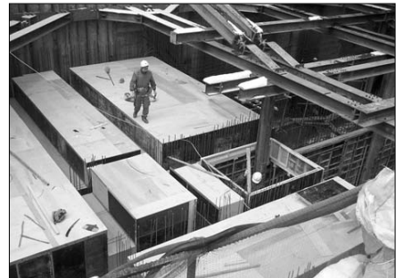
지하 2층부 철근배근 및 형틀조립작업
