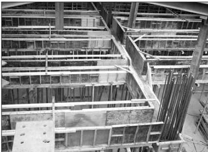
지하 1층부 철근배근 및 형틀조립작업
