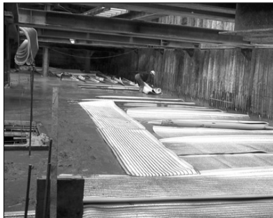
지하 2층 바닥콘크리트타설후 보양
