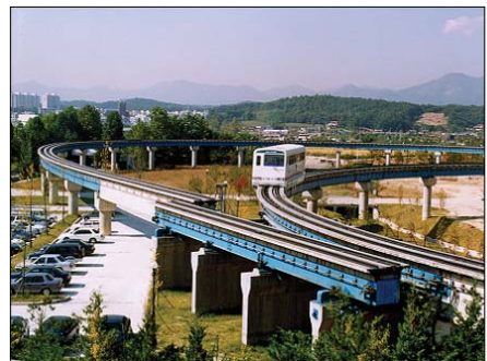
그림 1. 한국기계연구원 자기부상열차 시험선로 평면도. 최소곡선반경 : 60 m, 최대구배 : 6 % , 분기기구동방식 : 평행이동식
