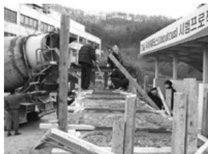
[사진 4] 1차 현장실험 콘크리트 타설
