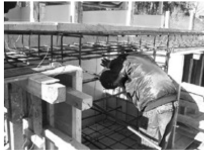
[사진 2] 1차 현장실험 게이지 설치
