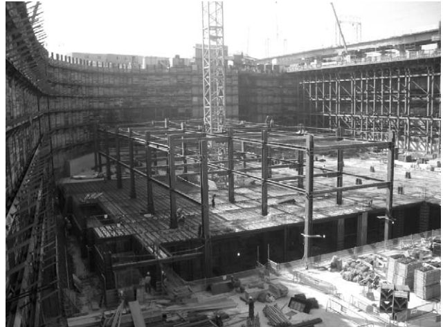
〈그림 7〉 신세계백화점 죽전점 시공사진
