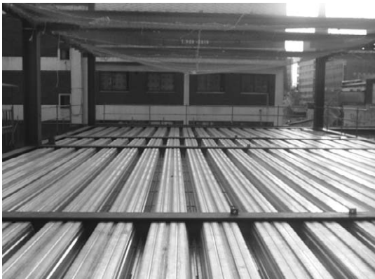
〈그림 6〉 삼성화재 청량리사옥 시공사진
