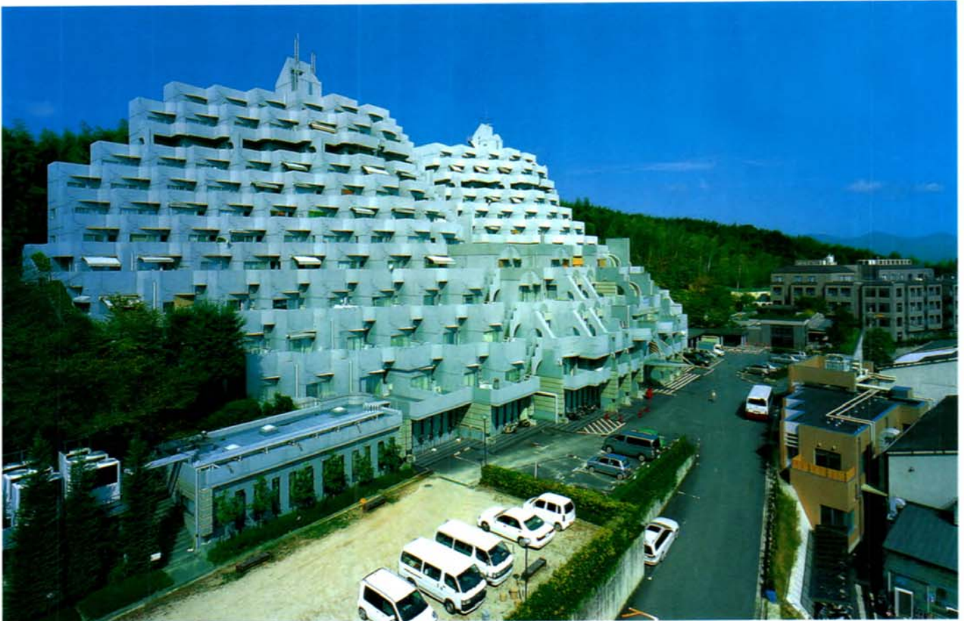
남쪽에서 본 전경. 독특한 외관은 시공 당시 '군함이나 별집' 같다는 말도 들었지만 현재는 주변 주민에게도 좋은 호감으로 받아들여지고 있다. 안에는 계단을 없앤 단체 간호형을 도입한 개별보호동이 보인다.
