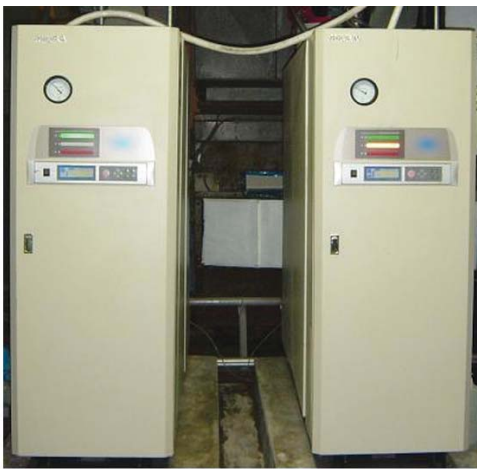
[그림 6] 신규 보일러 및 배가스 온도 측정
