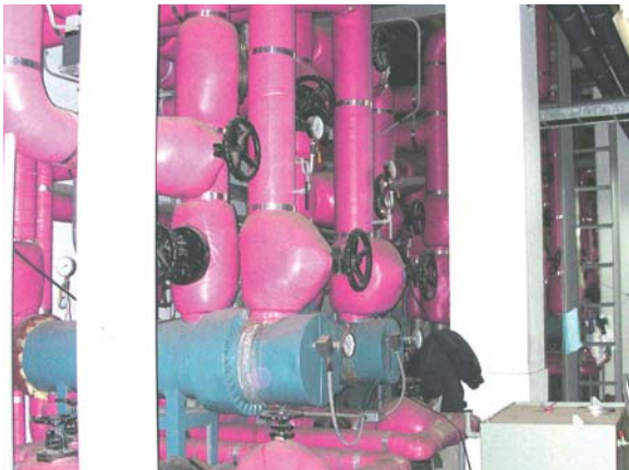
▶▶ 저효율 난방열교환기 및 간헐난방 시스템 공사전(左), 중온수 난방시스템 및 고효율 판형 열교환기 공사후(右)
