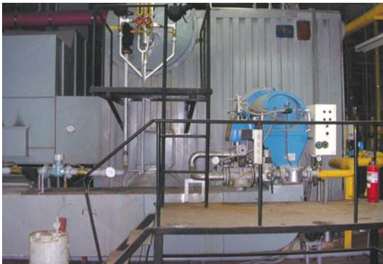
▶▶ 스팀보일러시스템 공사전(좌), 중온수보일러 공사후(우)
