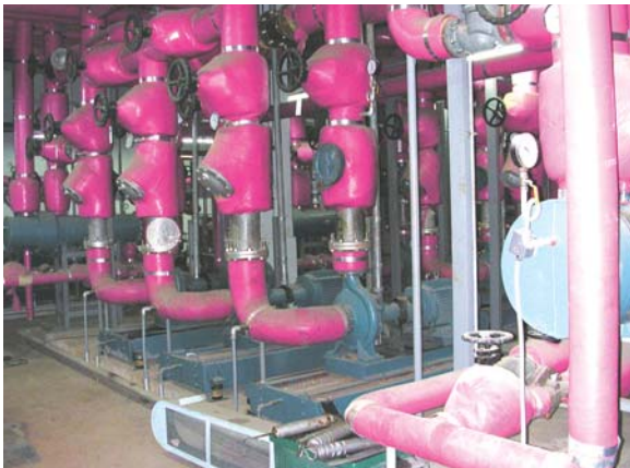
▶▶ 스팀난방배관 및 난방시스템 공사전(左), 중온수 환수 및 공급헤더 공사후(右)
