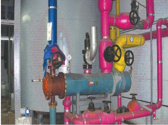
▶▶ 철재온수탱크 및 저효율 열교환시스템 공사전(左), 스테인리스급탕탱크 공사후(右)
