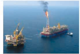
부유식 구조물 FPSO
