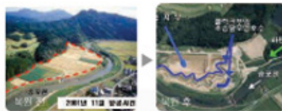
【 송포천 범람원 습지복원 전과 복원 후 】
