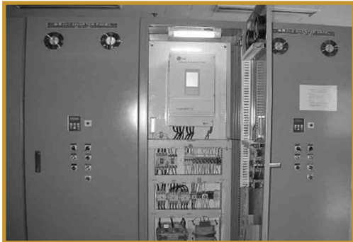
송풍기 풍량조절장치(인버터) 패널(3대) 설치
