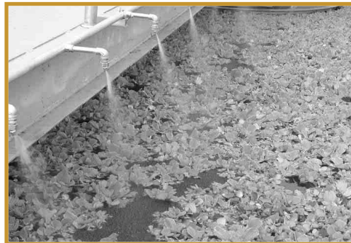
개선 후 : 소포설비 설치 및 부유수생식물(물상추, 부레옥잠) 재배
