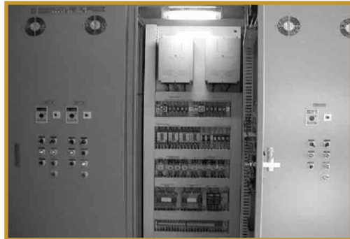
외부 및 내부반송슬러지 펌프 반송량 조절장치 (인버터) 설치 (외부 2대, 내부 3대)
