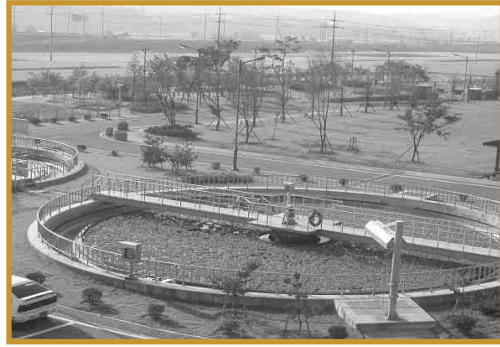
부유수생식물(물상추)이 2차 침전지를 완전히 덮은 모습
