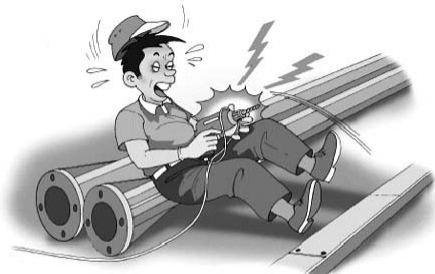
▲ 휴대용 전기드릴을 이용하여 천공작업 중 누전된 전기드릴에 감전 사망
