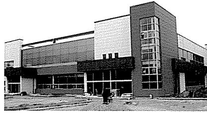
영춘 판넬의 난연3급 프로폴 샌드위치판넬은 뛰어난 보온성을 인정 받는 Expanded Poly Styrene(E·P·S)에 나노기술을 적용 특수처리하여 제조되는 프로폴과 Pre-coated Steel Sheet를 특수 접착 방식으로 Laminating한 Sandwich type의 난연판넬로서 각종 공장, 냉동창고, 주차타워, 상가 및 전시장, 사무실, 주택 등 어떠한 건축물에도 적용 가능한 난연판넬이다.
