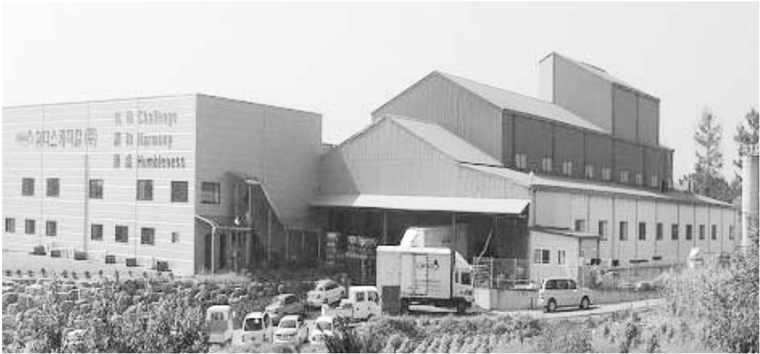
▲ 위더스케미칼 (주) 안성공장 전경
