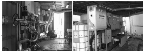
그림1 : <초음파 슬러지리액터> 그림2 : <벨트 중력농축기>
